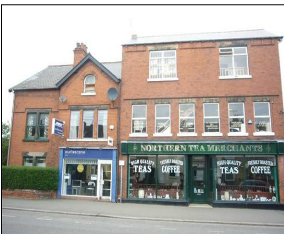
Nos. 193-197 Chatsworth Road
